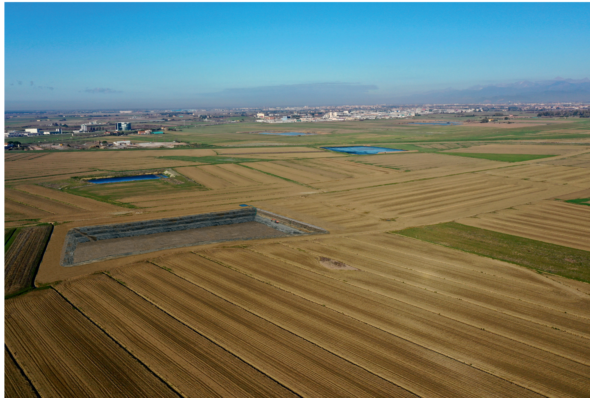
STATO INTERMEDIO DI SCAVO
