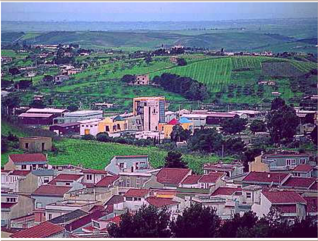
Una vista dell'abitato
