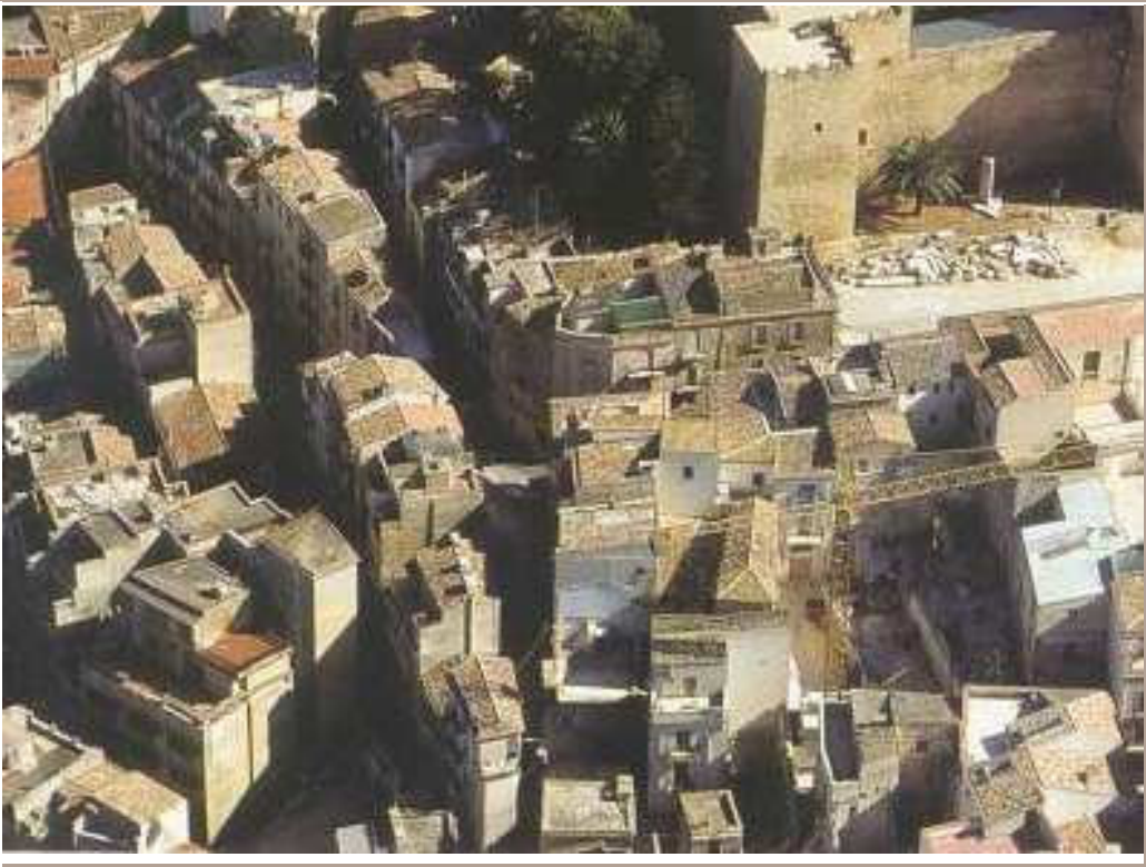
Particolare del tessuto edilizio
