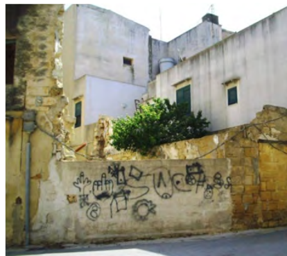
unità edilizia 17 "edifici allo stato di rudere"
