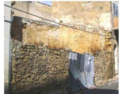
unità edilizia 12 "edifici allo stato di rudere"
