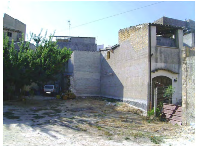
unità edilizia 43 "area di risulta dalla demolizione di fabbricati"
