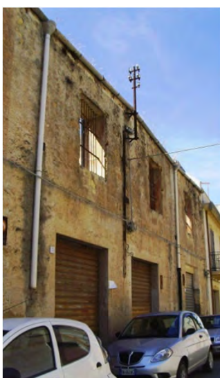
unità edilizia 10 "edifici allo stato di rudere"
