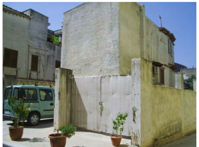
unità edilizia 7 (in costruzione)
