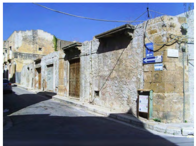
unità edilizia 32 "edifici allo stato di rudere"
