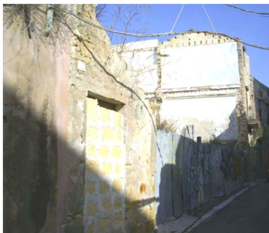
unità edilizia 4 "edifici allo stato di rudere"
