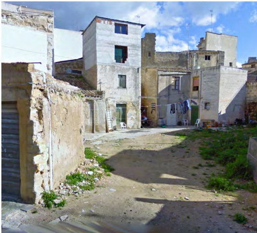
unità edilizia 40 "edifici allo stato di rudere"
