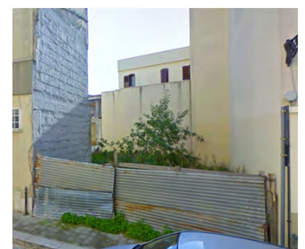
unità edilizia 8 "area di risulta dalla demolizione di fabbricati"
