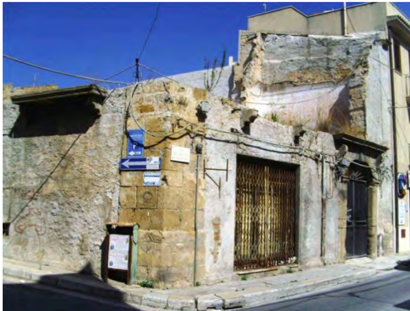
unità edilizia 32 "edifici allo stato di rudere"
