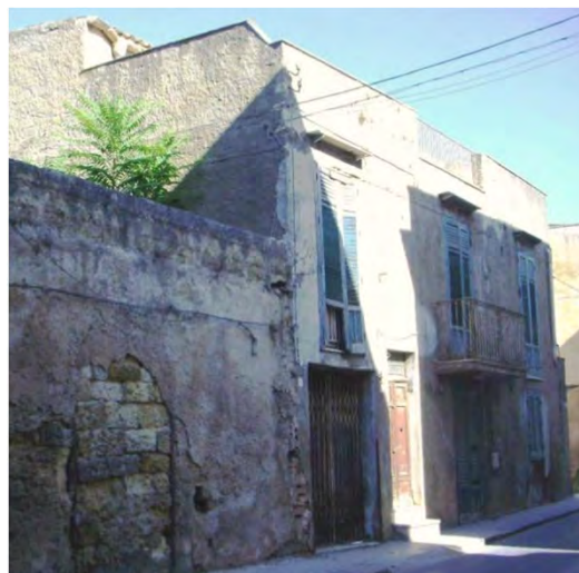
unità edilizia 3 "edifici allo stato di rudere"
