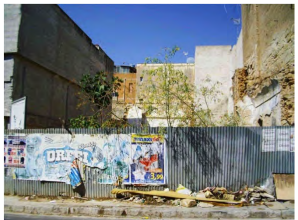
unità edilizia 26 "edifici allo stato di rudere"
