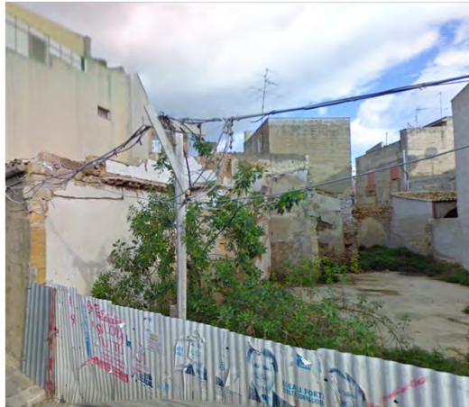
unità edilizia 10 "edifici allo stato di rudere"
