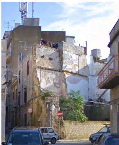
unità edilizia 1 "edifici allo stato di rudere"
