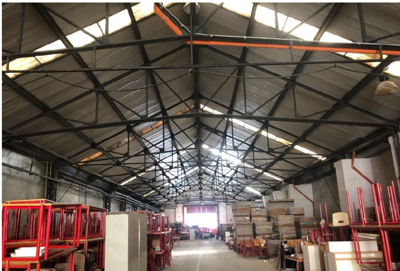
Foto 09 – Interno Open Hangar capannone 3
