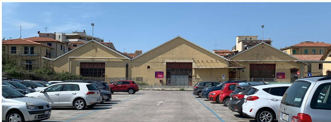
Vista degli Open Hangar dall'attuale parcheggio
