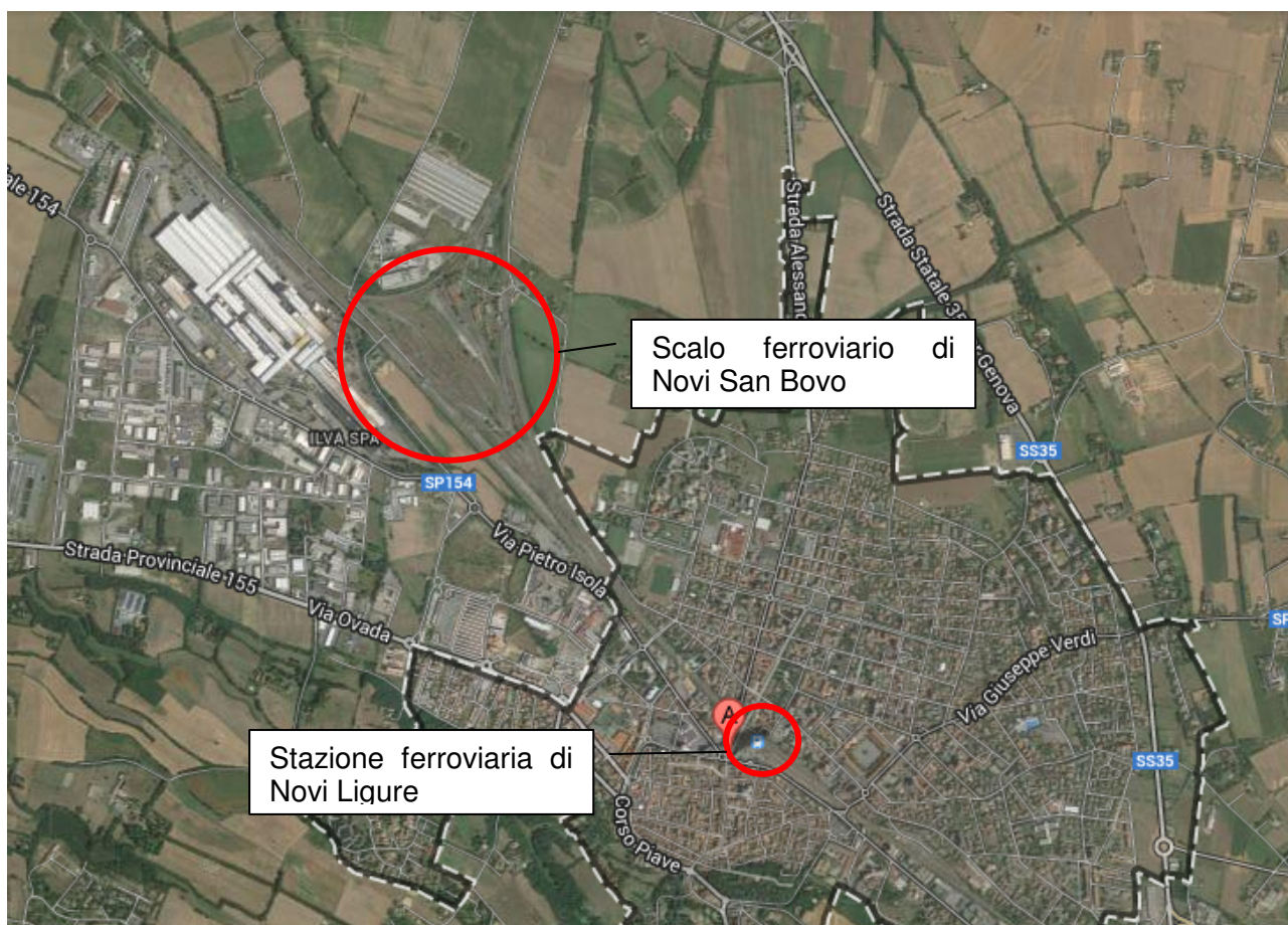
Figura 13. Stazione ferroviaria di Novi Ligure e scalo merci ferroviario di Novi San Bovo (Fonte: google maps)
