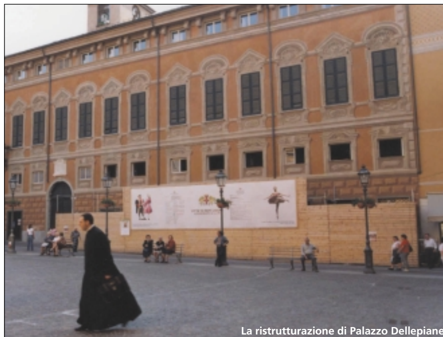
Lavori in corso per la realizzazione della piscina coperta
