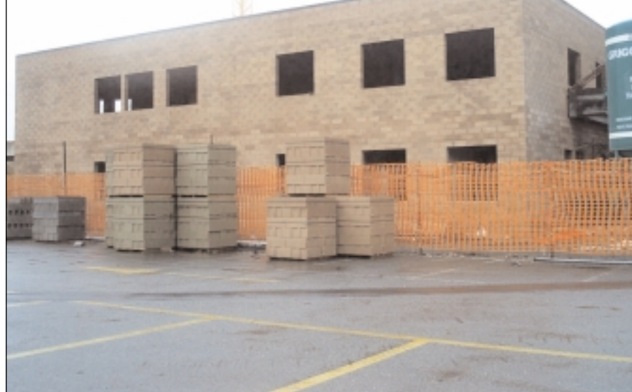
I lavori per la piscina coperta, accanto a quella estiva
