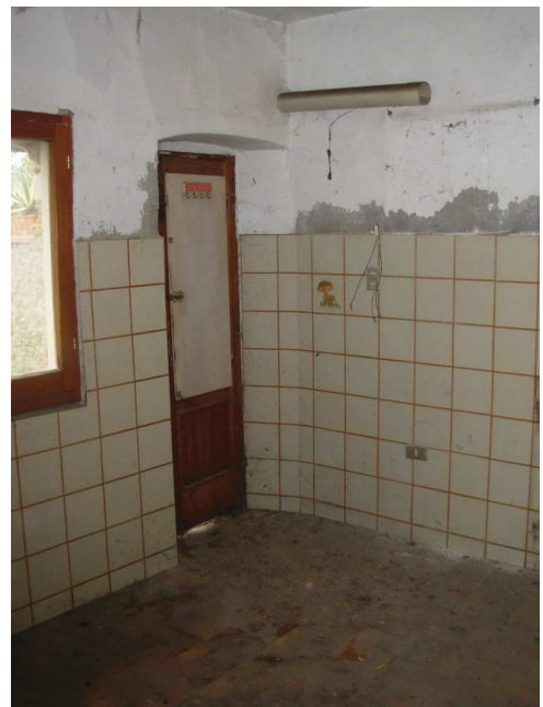
Cucina con vista porta accesso corte
