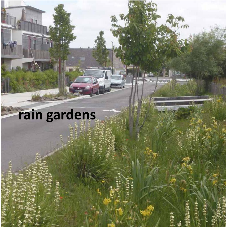
Rain gardens, Écoquartier Bottière Chênaie , Nantes © Bruel Delmar
