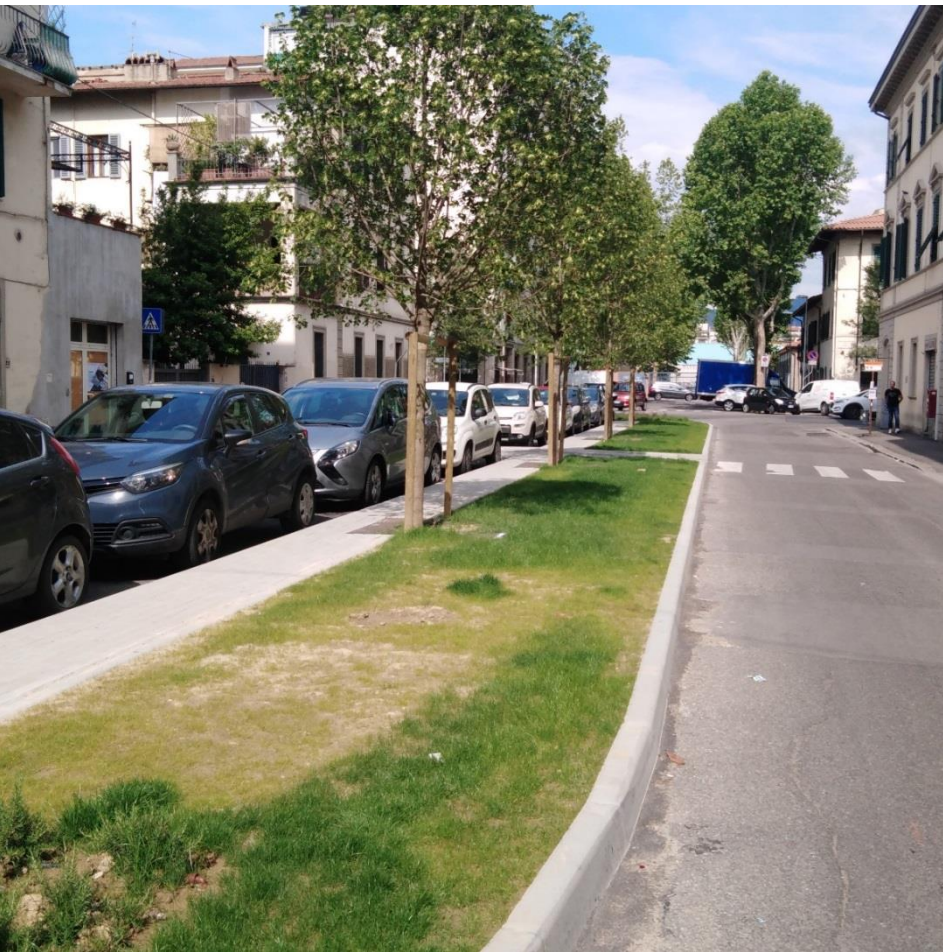
sistemazioni lungo strada tradizionali, Firenze
