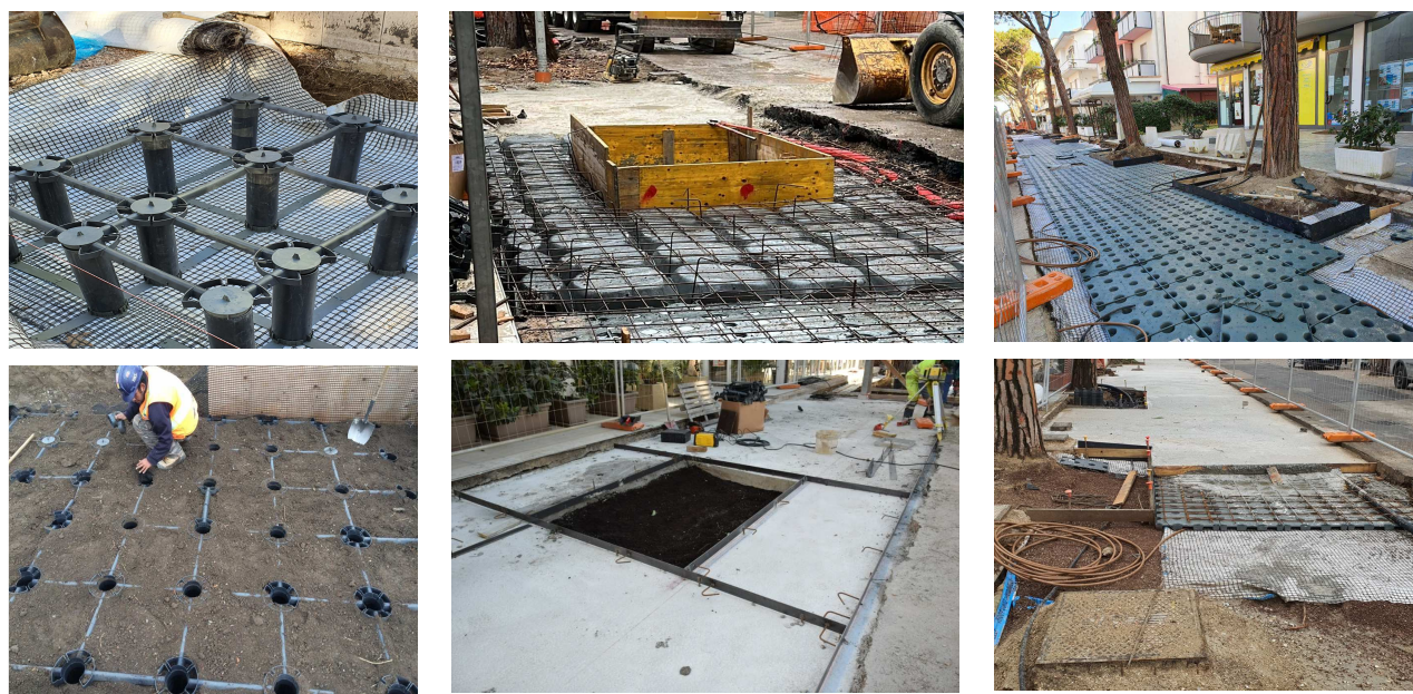
fig. 7.1 sistema di pavimentazione a celle vegetative (foto cantiere)
