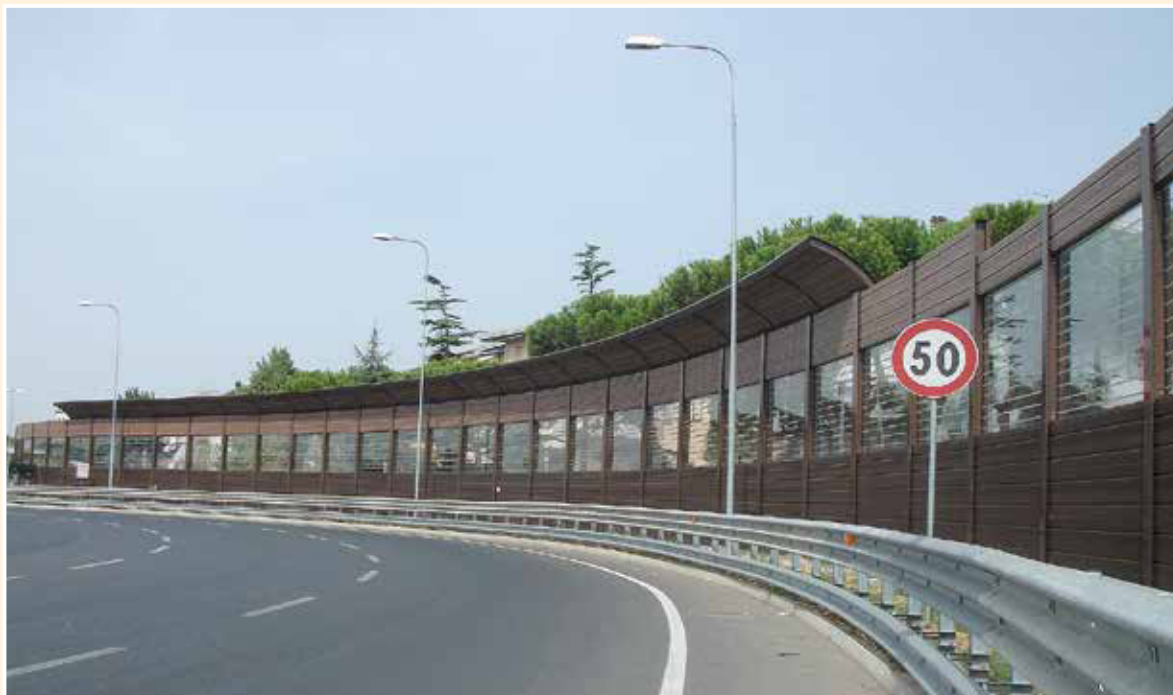
Pannelli silenti metallici in acciaio TECNOWALL 95 AV10
