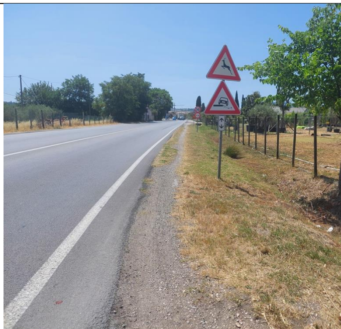
4_Vista della strada SP49 , Via Trasversale Marecchia
