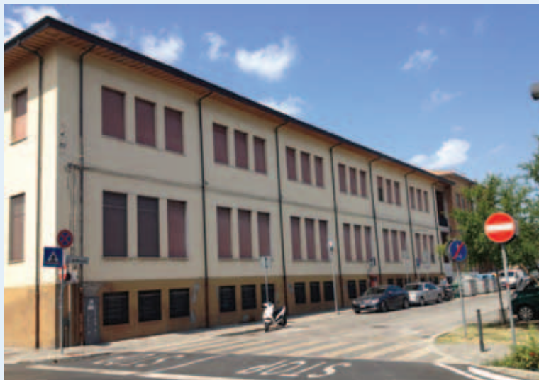
Via Giordano Bruno, l'ala della scuola elementare interessata dai lavori
