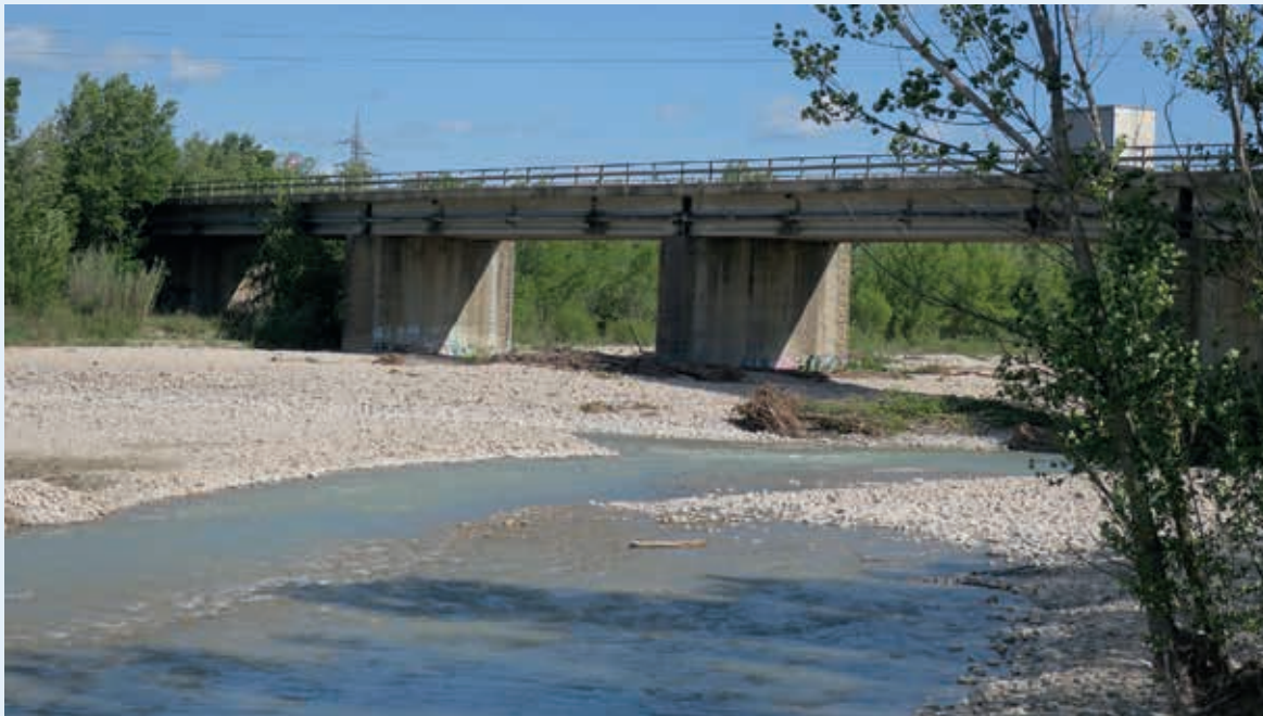
Il ponte sul fiume Marecchia
