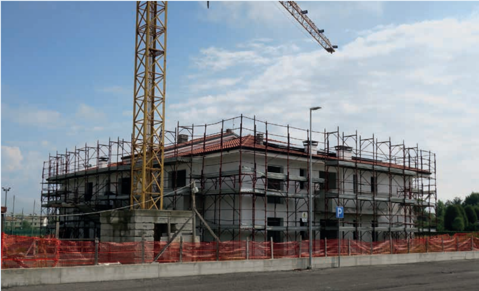
Via Di Vittorio, la palazzina in costruzione che ospiterà dieci appartamenti di edilizia residenziale pubblica. I lavori termineranno nel 2018
