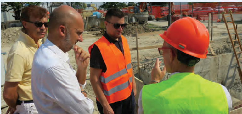
Cantiere di via Tosi, il sopralluogo dell'assessore ai Lavori pubblici Filippo Sacchetti assieme ai tecnici di Hera
