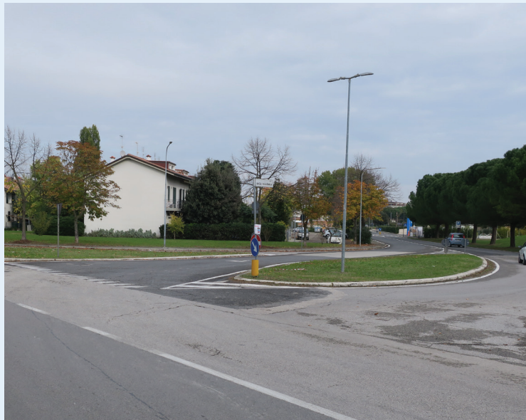
L'incrocio tra le vie Togliatti, della Resistenza e Franchini dove verrà realizzata la nuova rotatoria
