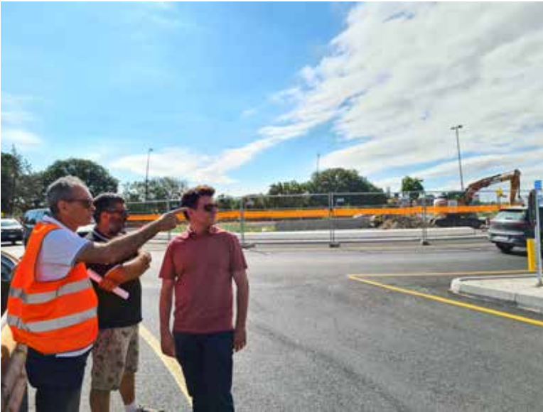
Il sopralluogo del sindaco Filippo Sacchetti alla nuova rotatoria in corso di realizzazione
